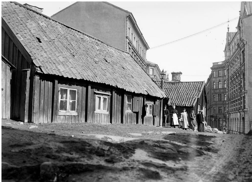
Den nya stadens stenhus möter den gamla trähusbebyggelsen. Bilden är tagen på Tegnér-gatan österut mot Västmannagatan. Foto: Oscar Heimer (1907), Stockholms stadsmuseum. Övre Norrmalm var då en utpräglad arbetarstadsdel, men i stenhusen på bilden bodde det framför allt mer välbärgade hushåll.
